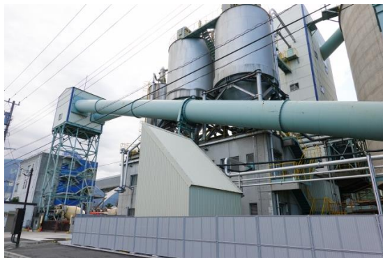
生コンの練りや配管のつまり
