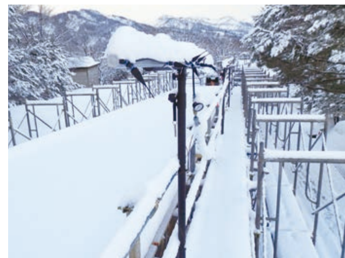
▲積雪荷重計測用の仮設屋根にレインカーテンを設置
